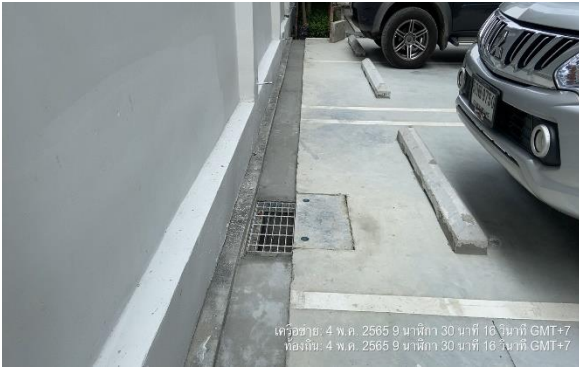
รูปที่ 30 ตะแกรงดักเศษขยะก่อนระบายออกสู่ ท่อระบายน้ำสาธารณะ
