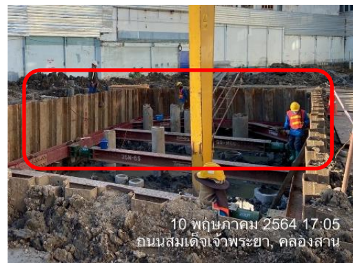
รูปที่ 6 การติดตั้ง Sheet Pile
