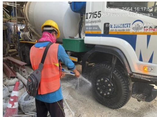
รูปที่ 10 การฉีดล้างล้อรถบรรทุก
