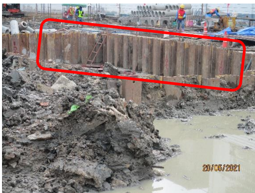
รูปที่ 6 การติดตั้ง Sheet Pile
